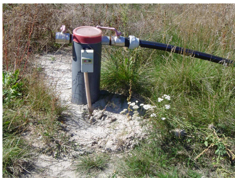
RYSUNEK 1. Indywidualne ujęcie wód podziemnych FIGURE 1. Individual source of underground water
