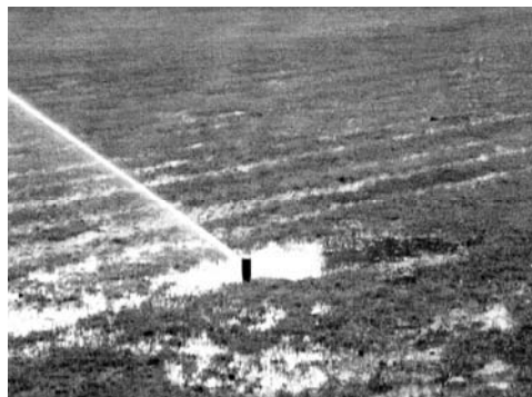
RYSUNEK 1. Fragment boiska po renowacji podczas deszczowania, widoczne lokalne stagnowanie wody
