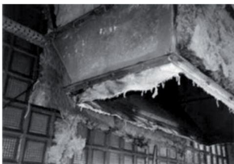
RYSUNEK 3. Płótno azbestowe w przewodach wentylacyjnych (PIP 2006, www.pip.pl) FIGURE 3. The asbestos canvas in the ventilation ducts (PIP 2006, www.pip.pl)
