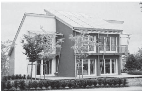
RYSUNEK 4. Dom pasywny wzniesiony w lekkiej technologii z prefabrykowanych elementów w szkielecie drewnianym firmy WeberHaus (Juchniewicz-Lipińska 2007)
