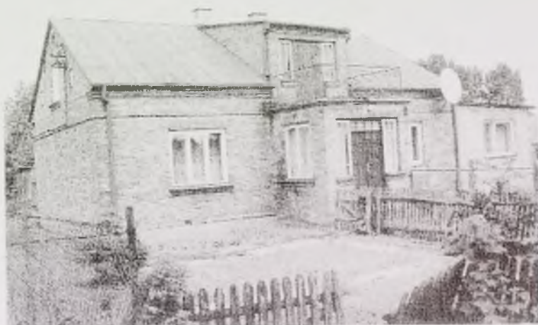
RYSUNEK 1. Budynek dwurodzinny we wsi Naruszewo (fot. M. Salak) FIGURE 1. Double-family house in Naruszewo village commune
