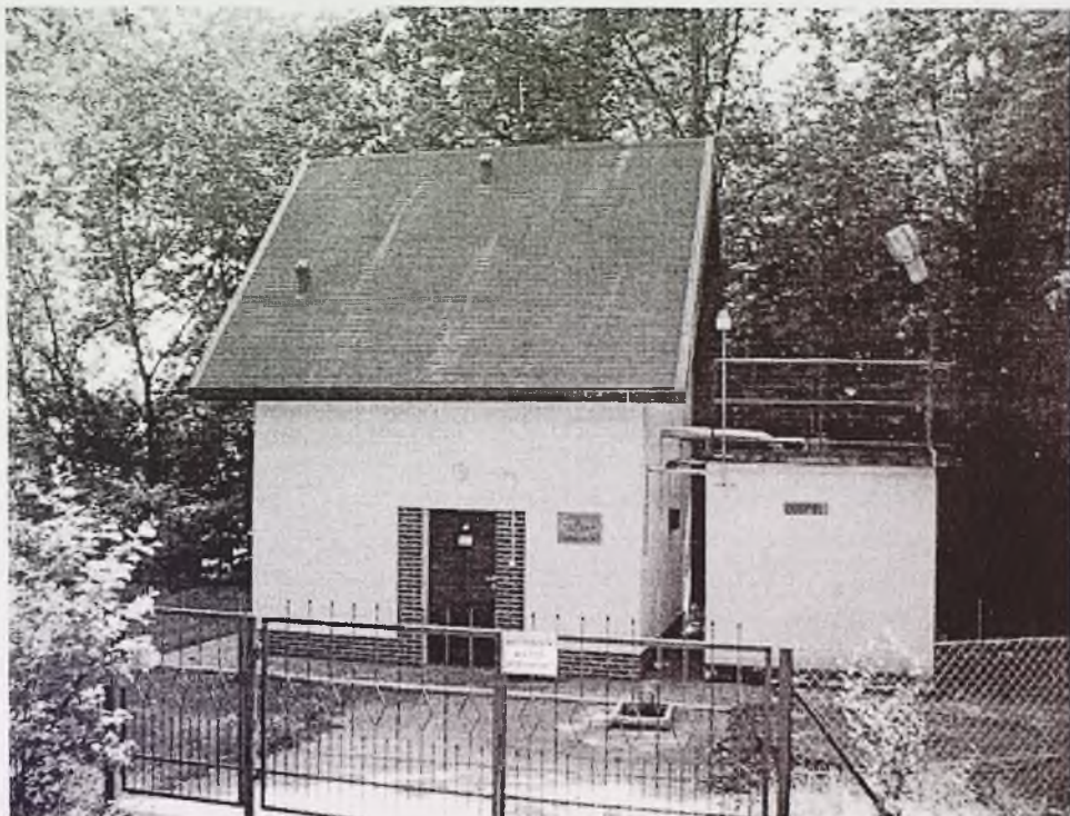
RYSUNEK 2. Oczyszczalnia ścieków w Ośrodku PAN w Mikołajkach FIGURE 2. Waste water treatment plant in PAN station in Mikołajki
